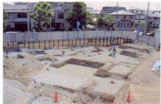
基礎工事現場
