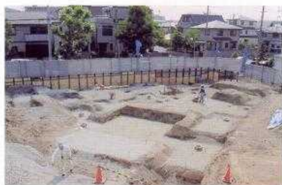
基礎工事現場
